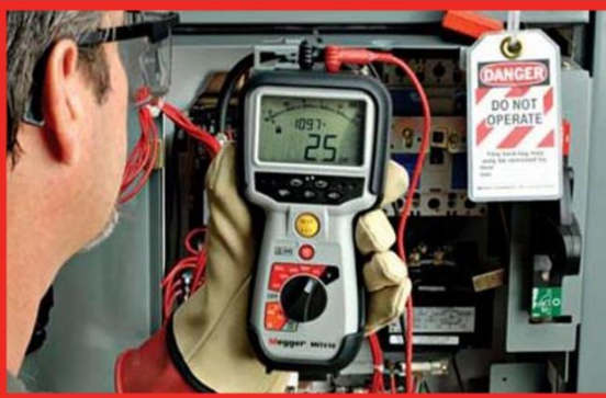
Měření izolačních stavů kabelu
